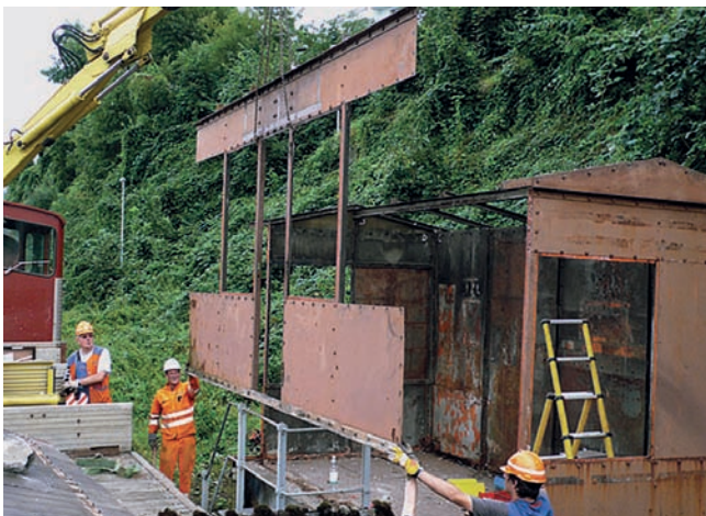
Rückbau der Stellwerkkabine in Rorschach
