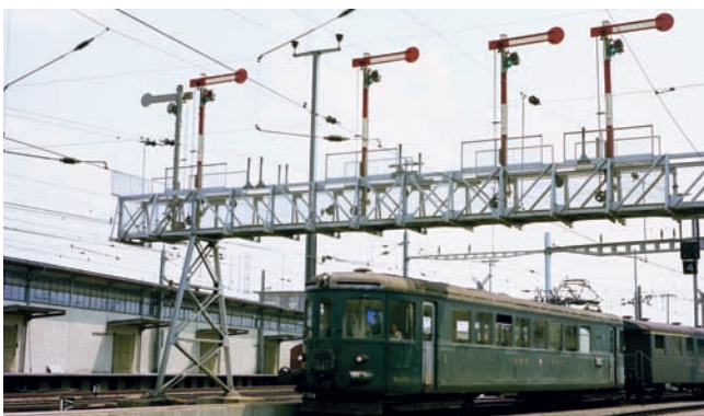
Ehemalige Signalbrücke in Romanshorn um 1976
