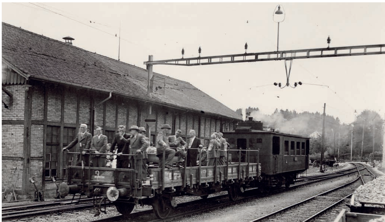
Mit dem Dampftriebwagen der UeBB auf Inspektionsfahrt (Bahnhof Hinwil 1947)
