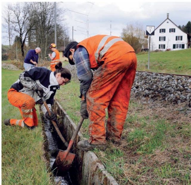
Streckenunterhalt: Reinigung der Abwasserrinnen
