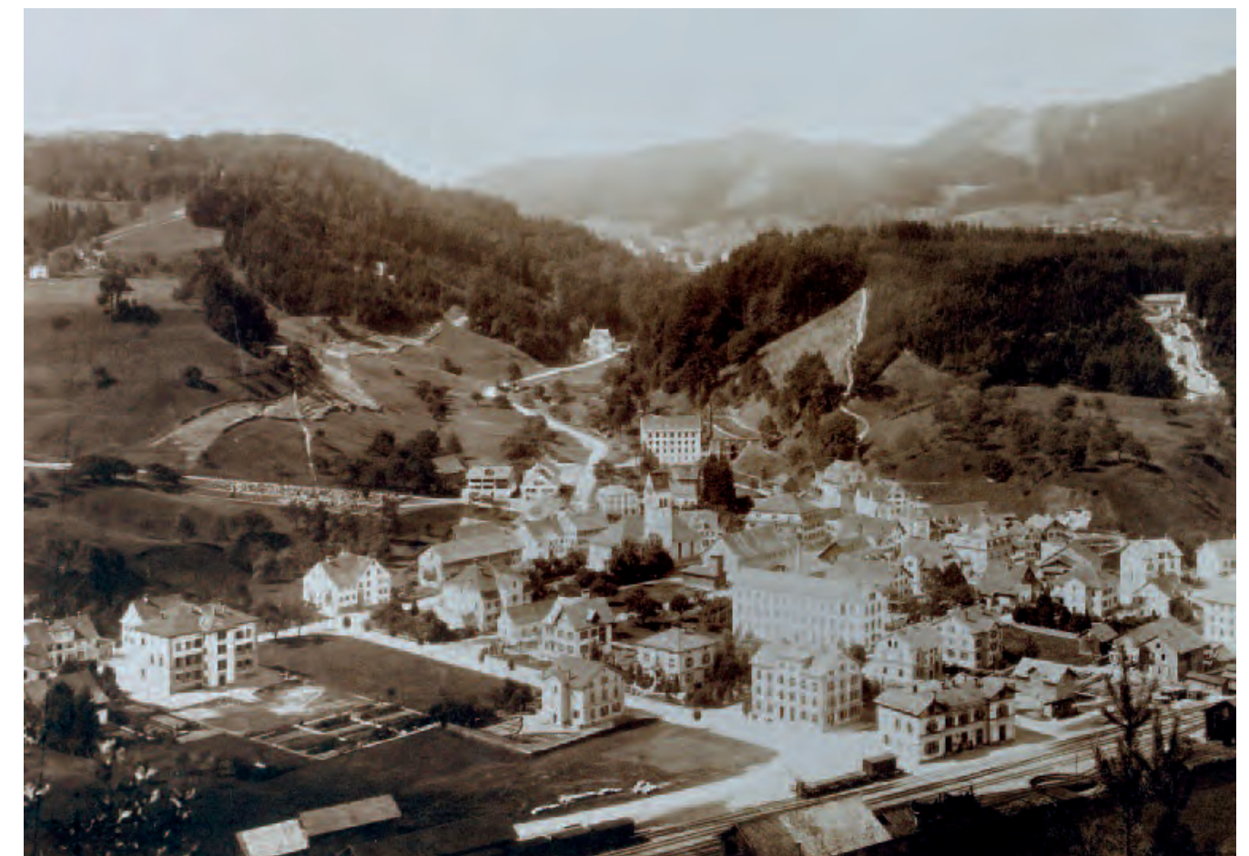
Bauma, erste Arbeiten am Trasse der UeBB beim Wolfsberg (links im Bild)
