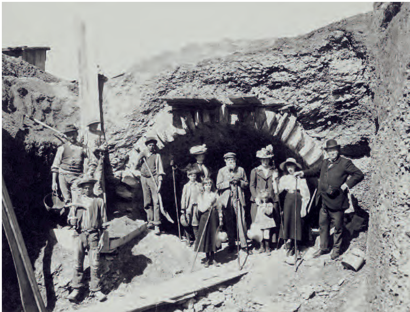
Im Jahr 1897 besuchte Guyer-Zeller mit seiner Familie die Baustelle beim Eigergletscher
