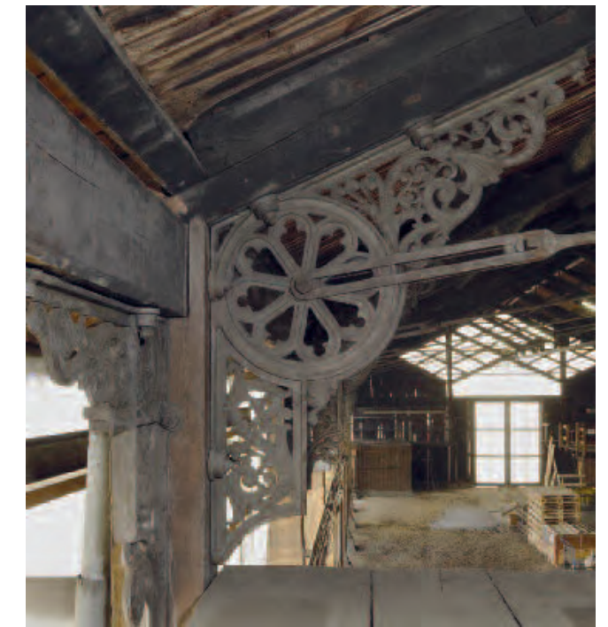
Die gusseisernen Konstruktions- und Zierelemente sind fast komplett erhalten geblieben
