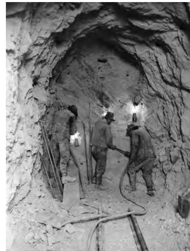
Mineure beim Tunnelvortrieb in der Eigerwand
