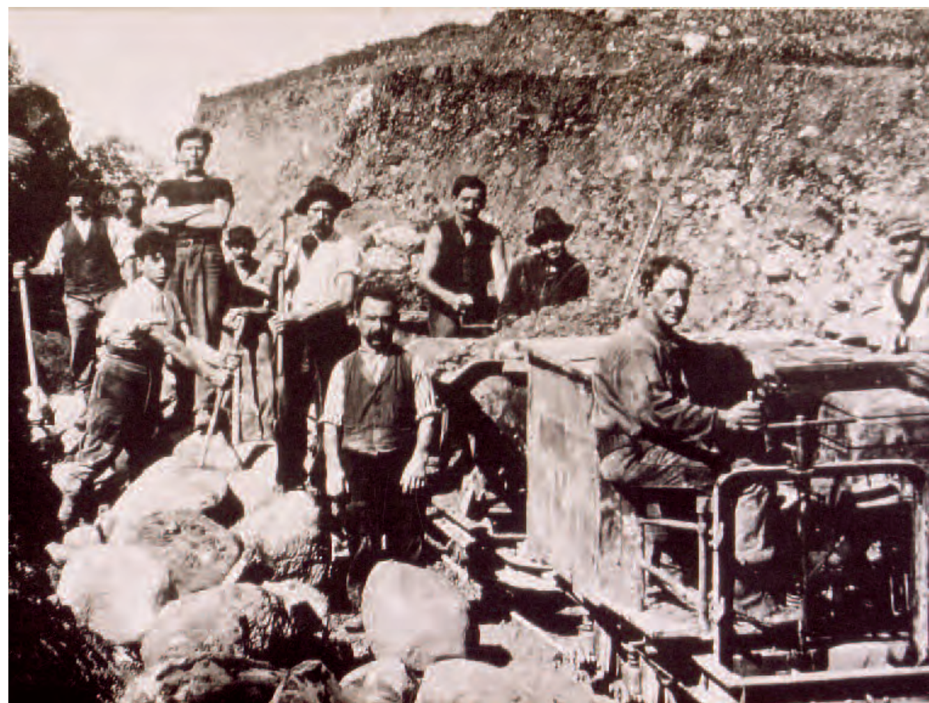
Auf der gesamten UeBB Strecke waren für die unzähligen Einschnitte und Dämme aufwändige Erdverschiebungen notwendig
