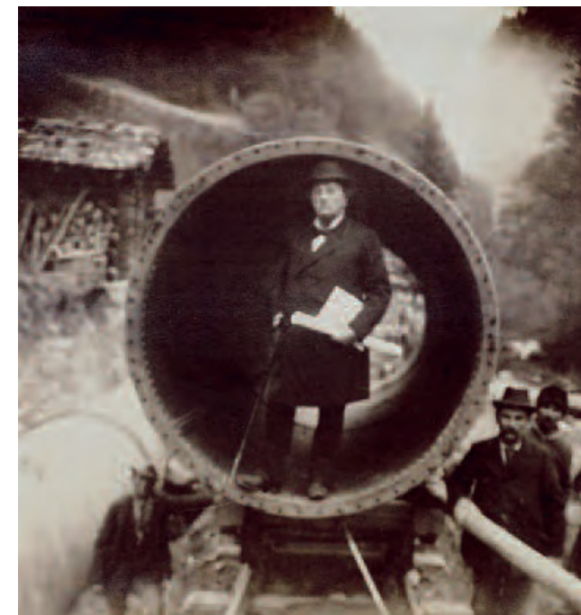
Guyer-Zeller inspiziert die Arbeiten beim Kraftwerk Lauterbrunnen (1897)
