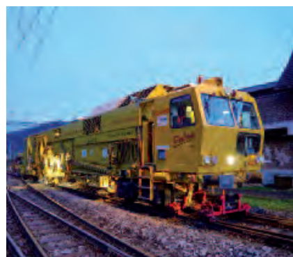
Sersa-Einsatz im April 2012 in Bauma
