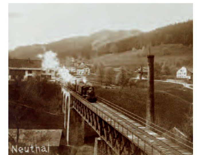
UeBB Dampfzug auf der Weissenbachbrücke bei Neuthal
