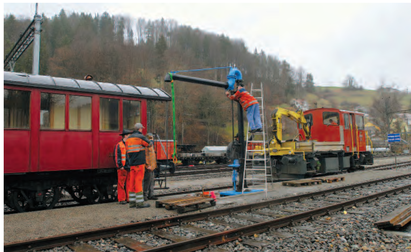
Montage eines Wasserkrans auf dem neugestalteten Dampfbahnperron in Bauma
