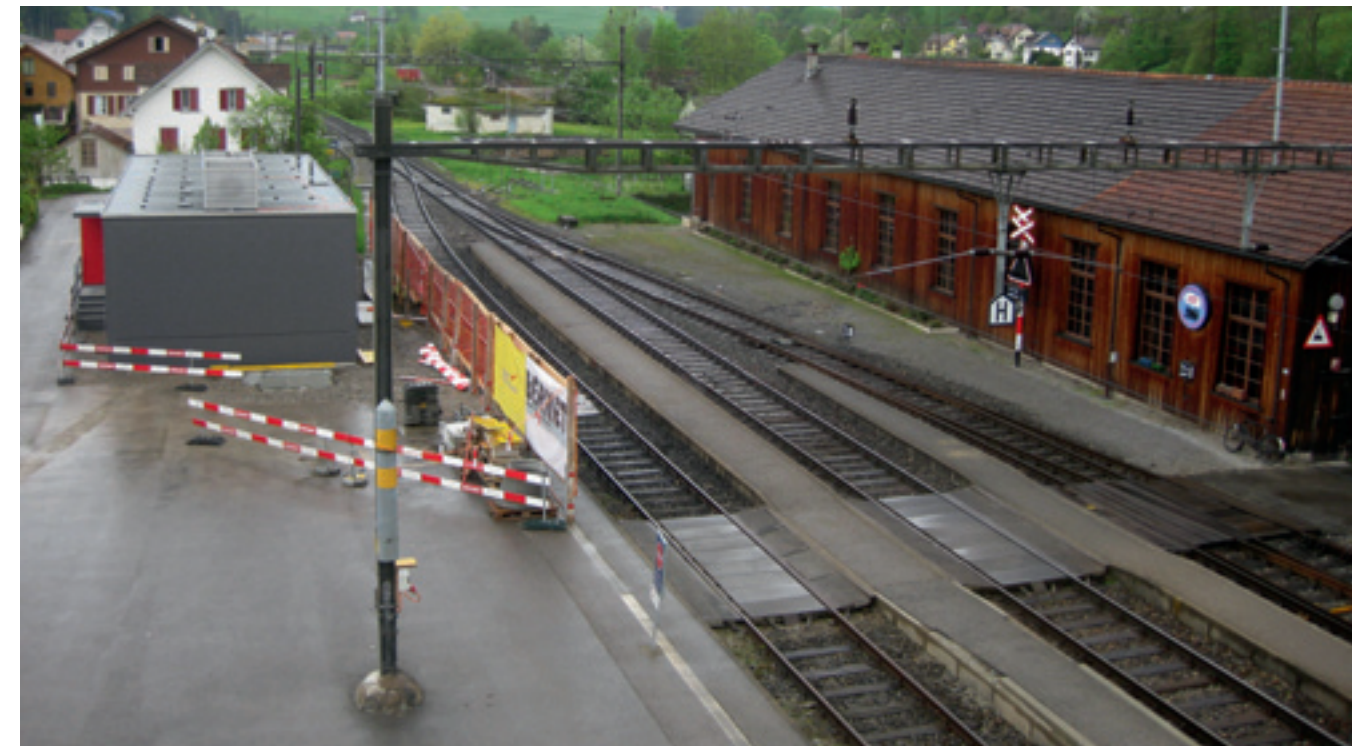
Mitte Mai 2013 steht schon das Bahntechnikgebäude, welches das neue Stellwerk sowie die Niederspannungs- und Fernmeldetechnik des Bahnhofs Bauma beheimatet. Der Bahnübergang zur DVZO-Remise verschwindet per Mitte Juni 2013.
