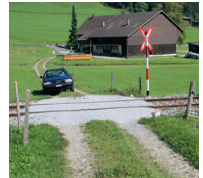
An diesem landwirtschaftlichen Übergang wurde soeben eines von zwei Andreaskreuzen montiert
