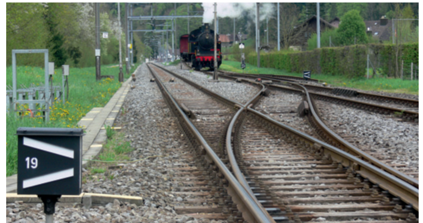
Die Weiche 19 verbindet in Bauma das SBB-Hauptgleis mit dem Streckengleis des DVZO
