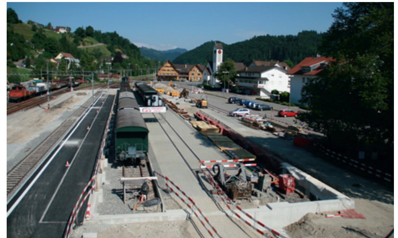
Auf gutem Grund: der Bau des Fundaments für die Halle wurde 2013 abgeschlossen
