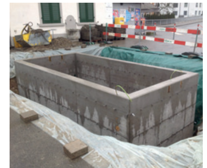
Fertiges Fundament für das Stellwerkgebäude in Bäretswil
