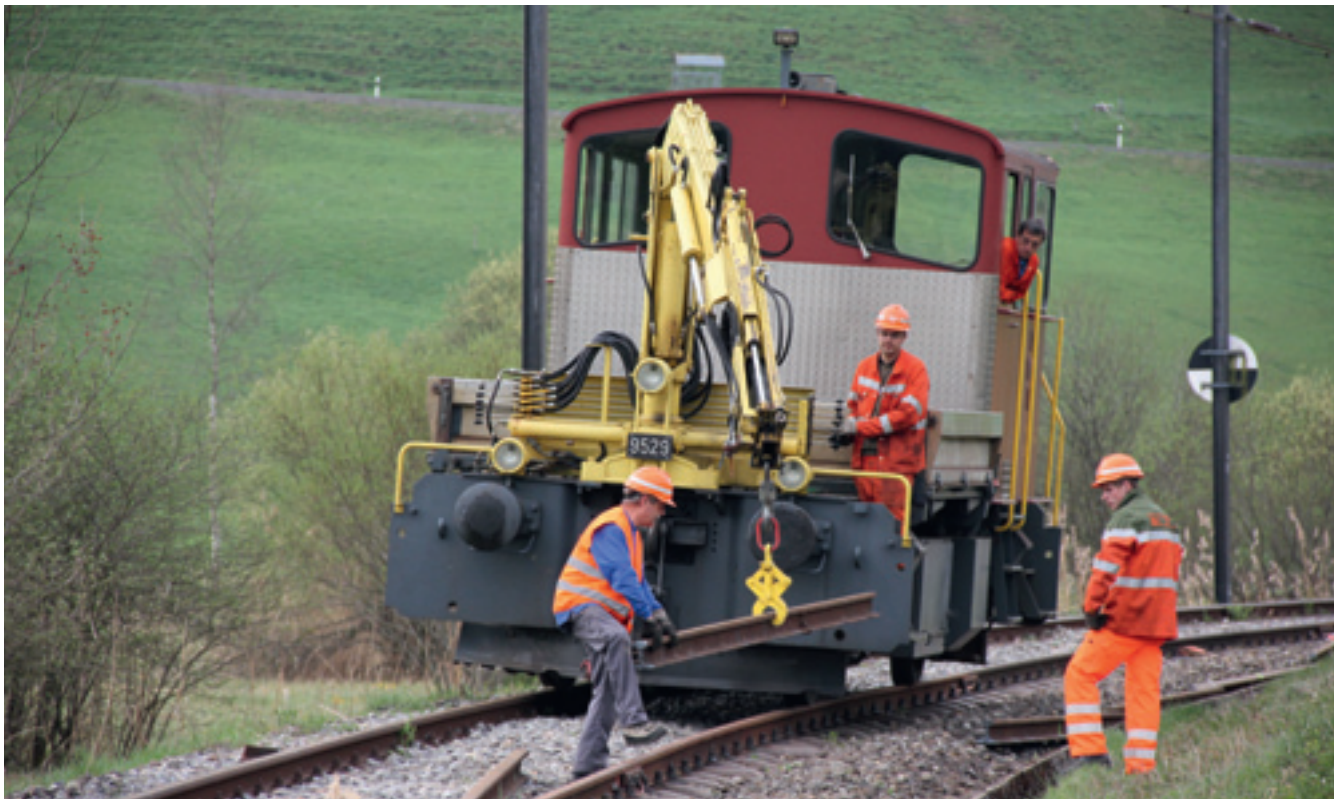
Auch das gehört zum Erhalt des Kulturgutes Eisenbahn: die Erneuerung des Schienenmaterials auf der Dampfbahnstrecke.
