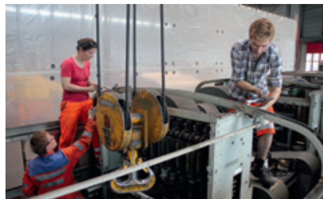
Arbeiten rund um die Trafosrevision in der Sersa-Halle in Hinwil, Ausbau der Hüpferrbatterie
