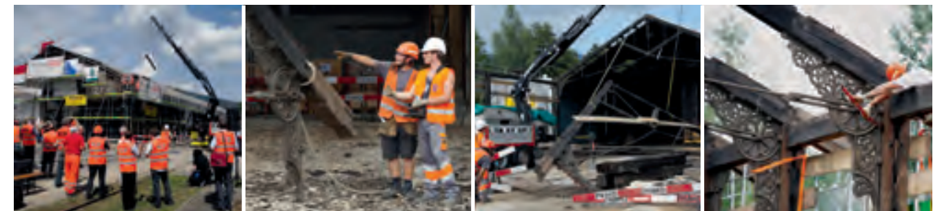
Massarbeit: Vom August bis Dezember 2012 wird die Halle in Olten Teil für Teil sorgfältig demontiert.
