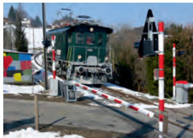
Der sanierte Bahnübergang Hinterwis in Bauma
