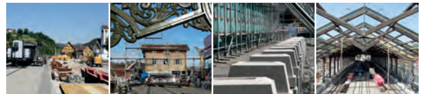
Die Halle kommt: spektakuläre Aufrichte eines Baudenkmals von nationaler Bedeutung in Bauma
