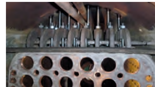
Das hält wieder! Die Feuerbüchsendecke mit neuen Deckenankern.
