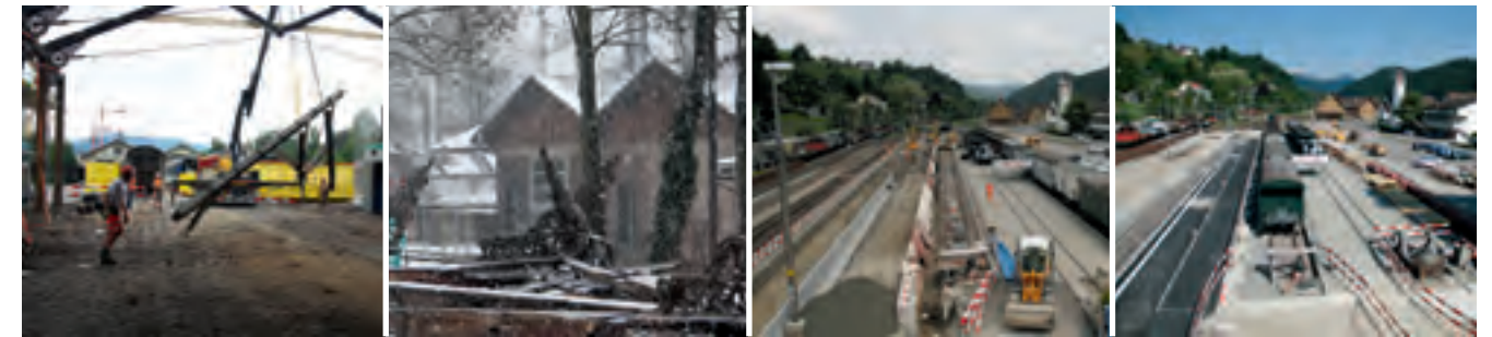
Bis es schneit: Abschluss der Demontage in Olten
