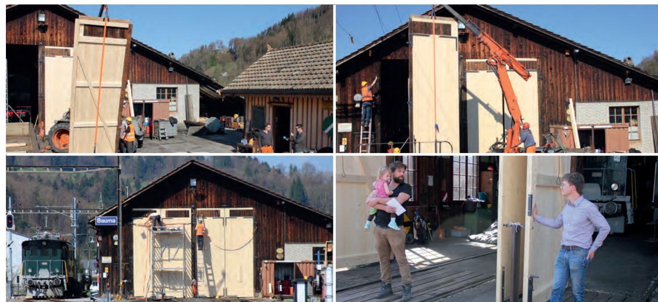
Florian Schlegel, Lerch AG und Florian Vogel, DVZO öffnen gemeinsam die 5.6 m hohen, frisch renovierten Depottore
