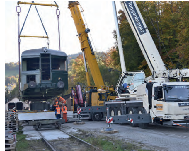
Am 16. Oktober 2017 wird der revidierte Transformator eingebaut.
